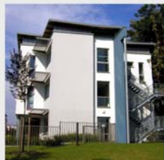
Neubau Landratsamt Gabelstrasse Gotha
